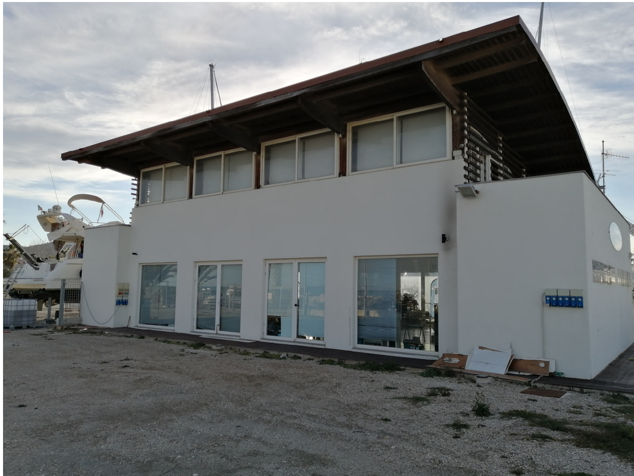
FORO N. 1 – LATO NORD-EST
